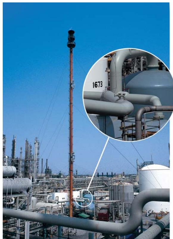
GF868现场的典型安装示意。详图显示传感器安装在通往火炬气储罐的火炬气主管上
